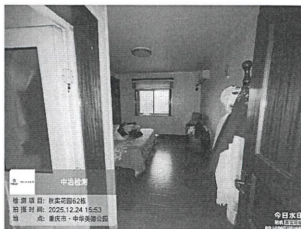
图 4-4：构件外观现状
