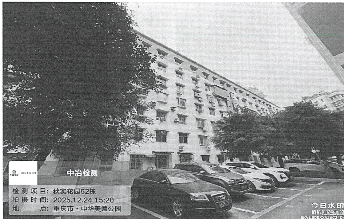
图 1-1：房屋立面现状
