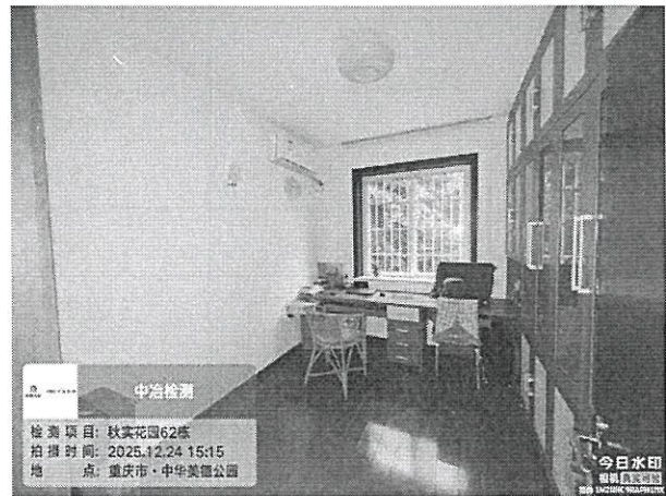
图 4-7：围护构件外观现状
