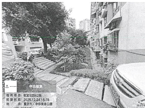
图 4-2：房屋背面场地现状
