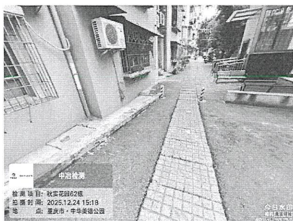
图 4-1：房屋正面场地现状
