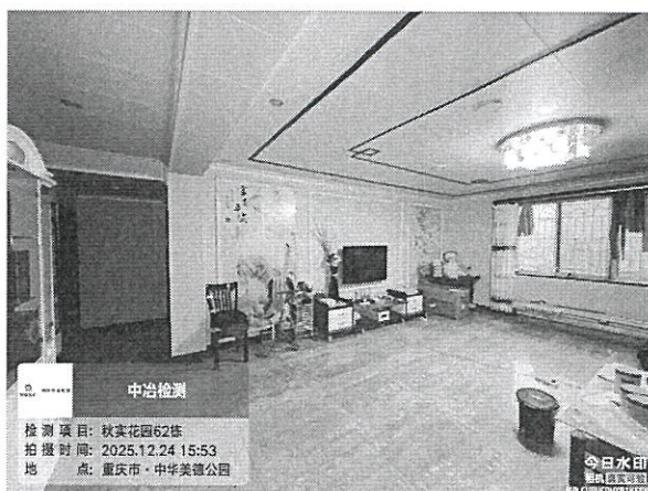
图 4-3：构件外观现状
