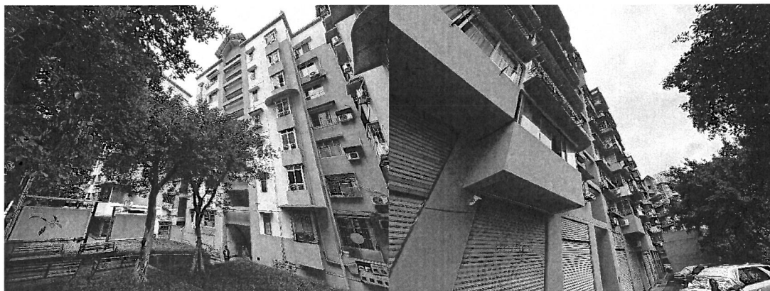
图 1-1 房屋外观现状
