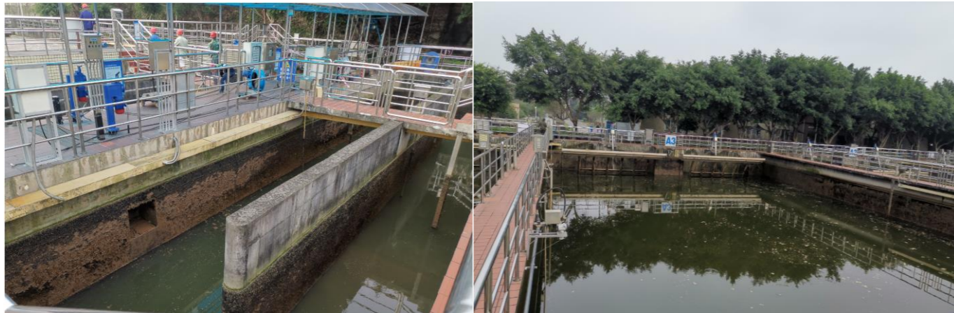
图 7.1-20 大渡口污水处理厂实景图
