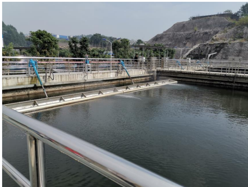
图 7.1-21 大九污水处理厂实景图
