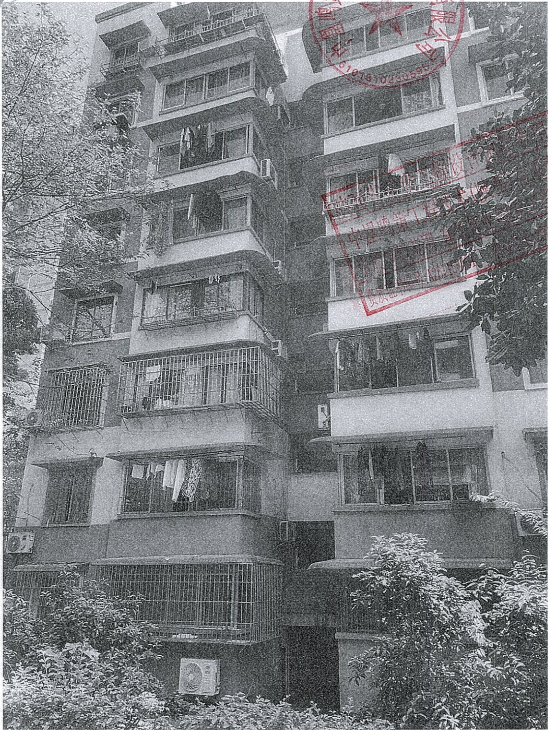
图 1.1 拟加装电梯建筑物现状
