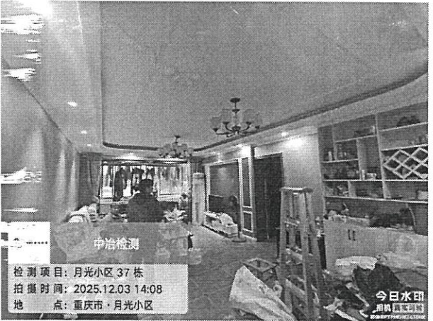
图 1-8：房屋内部现状
