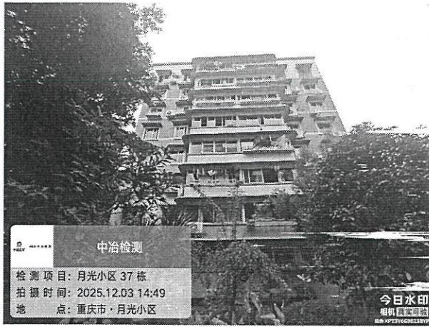
图 1-5：侧面外观现状
