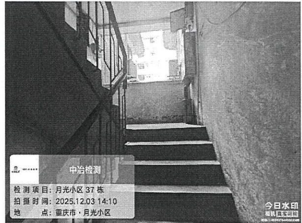
图 1-12：房屋楼梯现状
