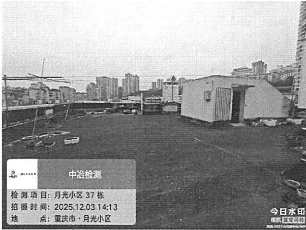
图 1-11：房屋屋面层现状
