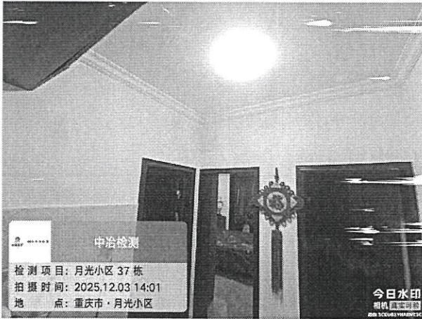
图 1-7：房屋内部现状
