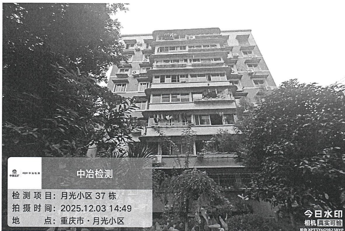
图 1-1：房屋正立面现状
