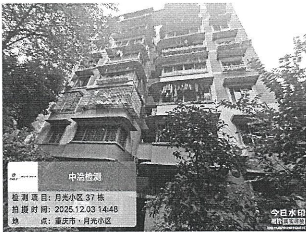
图 1-3：正面外观现状
