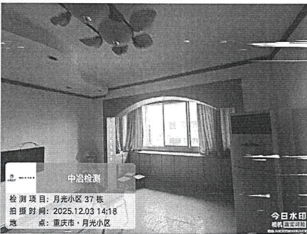
图 1-9：房屋内部现状
