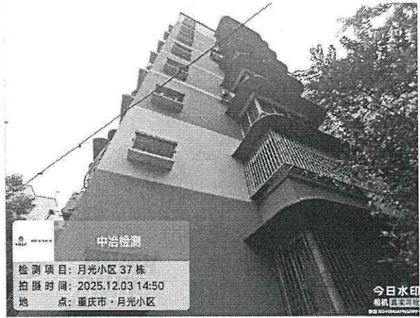
图 1-4：侧面外观现状
