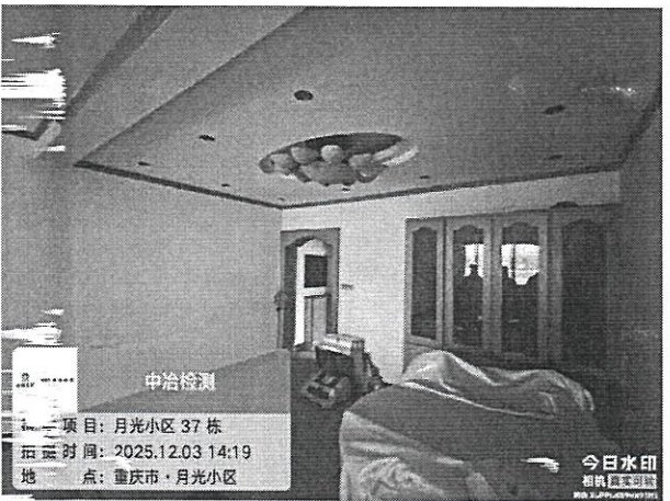
图 1-10：房屋内部现状
