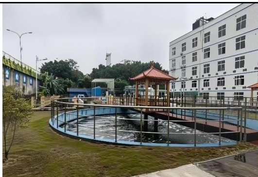
综合废水处理站
